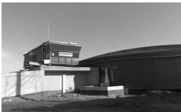
Rys. 11.4. Zasobnik przyjęciowy, zbiornik fermentacyjny oraz wziernik kontrolny ze szperaczem umożliwiający kontrolę prawidłowości procesu fermentacji (biogazowni rolnicza w Kalsku (PL) – fot. A. Myczko)
