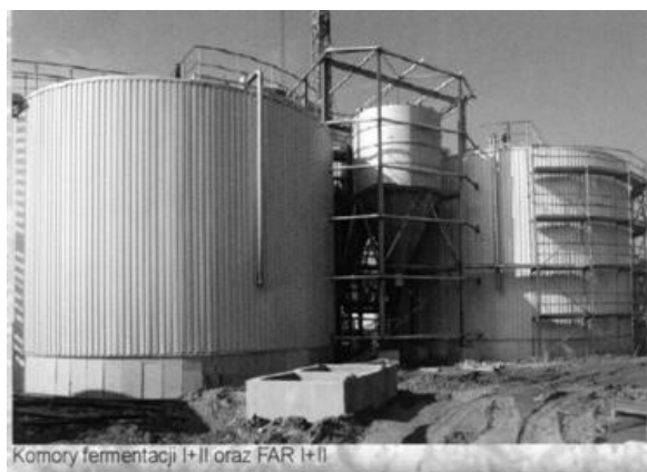
Rys. 11.6. Biogazownia do utylizacji pozostałości z przetwórstwa warzyw i owoców prowadząca dwustopniowy proces fermentacji w zakresie termofilnym i mezofilnym oraz ciągłą sedymentację i recyrkulację wsadu (fot. mat. Firmy LimnoTec –D).
