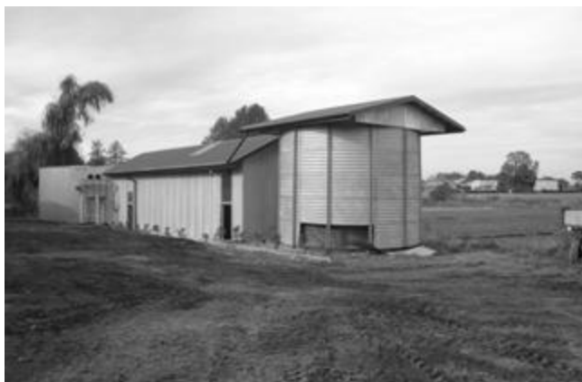
Rys. 11.3. Mikrobiogazownia rolnicza w Studzience k/Pszczyny (fot. A. Myczko)
