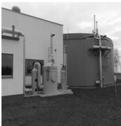
Rys. 11.5. Węzeł przyjęcia i obróbki substratów uciążliwych – odpadów poubojowych w biogazowni w Skrzatuszu k/Piły zbudowanej przez firmę ZENERIS. Obróbka odbywa się w zamkniętych pomieszczeniach, zastosowano filtry antyodorowe hal i zbiorników substratowych (fot. A. Myczko)
